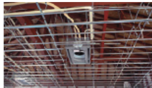
空調設備工事
