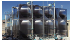
給排水衛生設備工事
